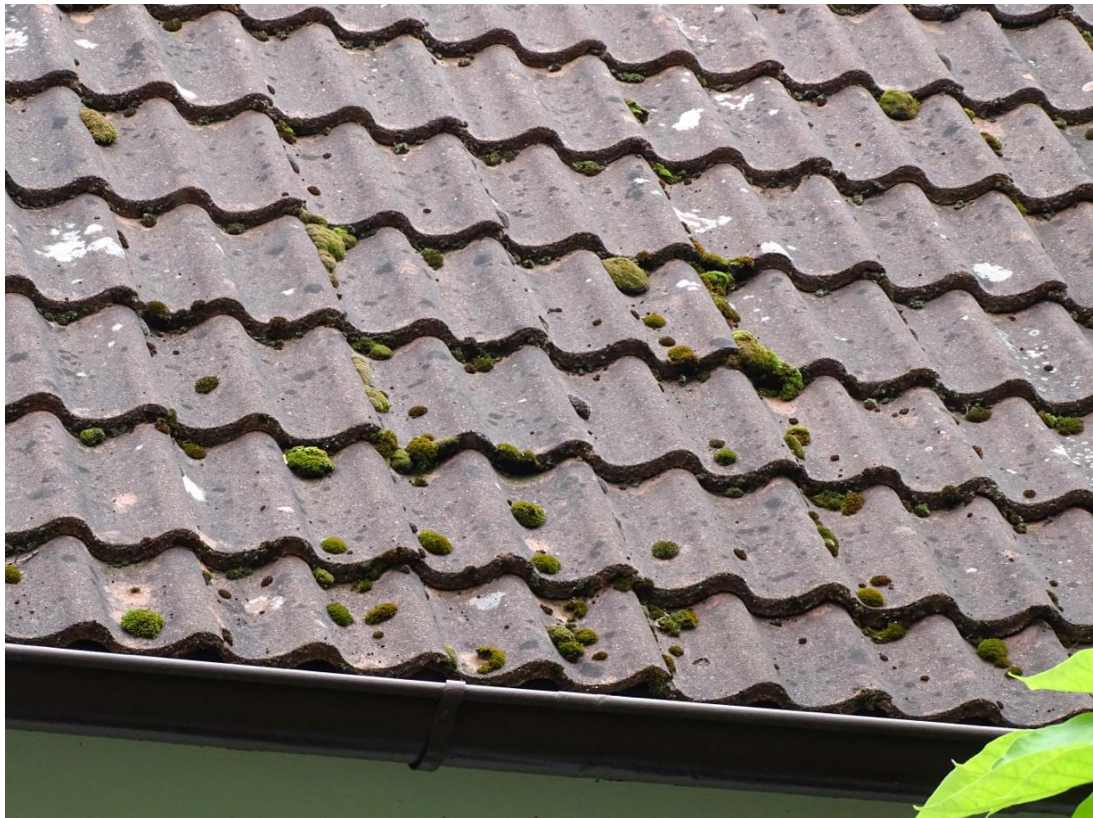
Fot. 7. Dach starej części budynku do oczyszczenia
